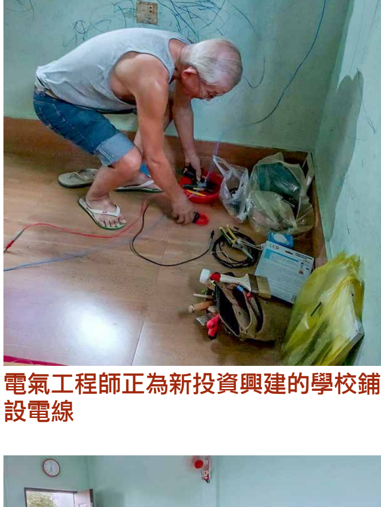
電氣工程師正為新投資興建的學校鋪設電線
